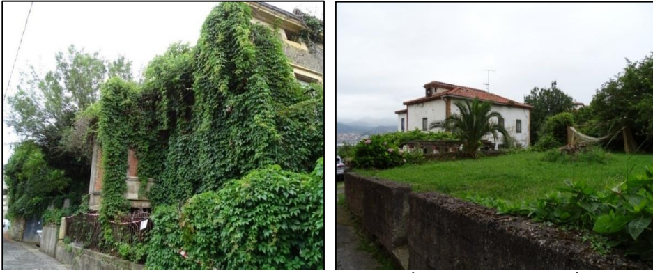
Foto 16. Vista del edificio abandonado situado al oeste del ámbito (desde San Nicolás Kalea) y jardín y vivienda desde el norte
